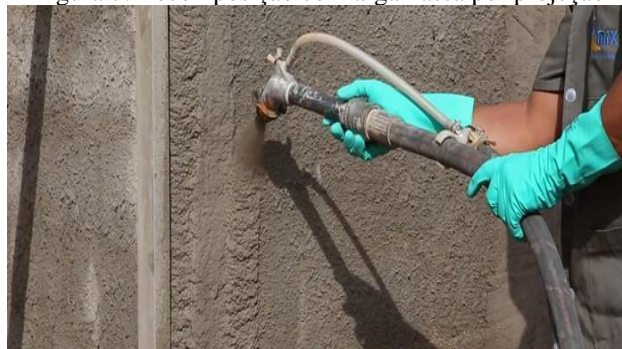
Figura 7: Recomposição com argamassa por projeção
