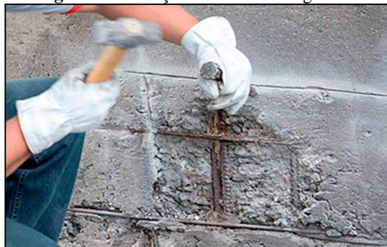
Figura 3: Remoção do concreto degradado
