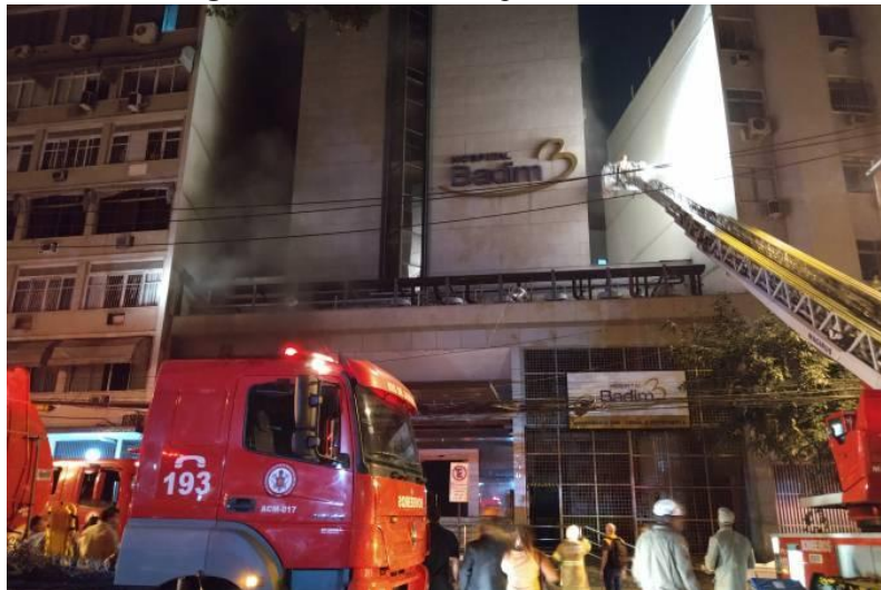
Figura 1: Incêndio no Hospital Badim do RJ
