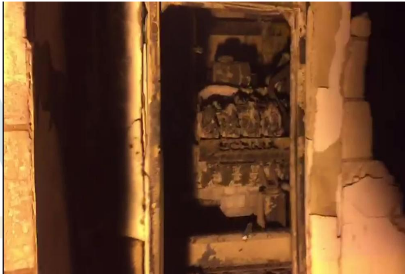
Figura 3: Gerador do Hospital do Badim no subsolo da unidade de saúde
